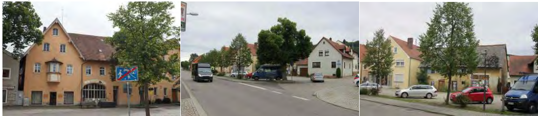
Straßenrandbereiche Hauptstraße, Aufweitung Münchener Straße
