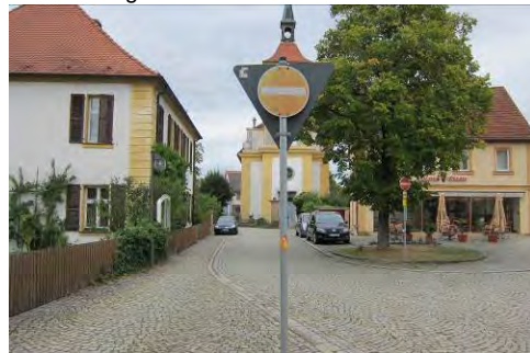
Münchener Str. Einmündung St. Gotthardskirche
