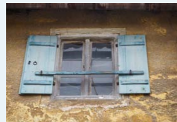
In Thalmässing zeigen noch viele historische Gebäude wie Fassadenöffnungen angeordnet und Fenster konstruktiv ausgeführt wurden.
