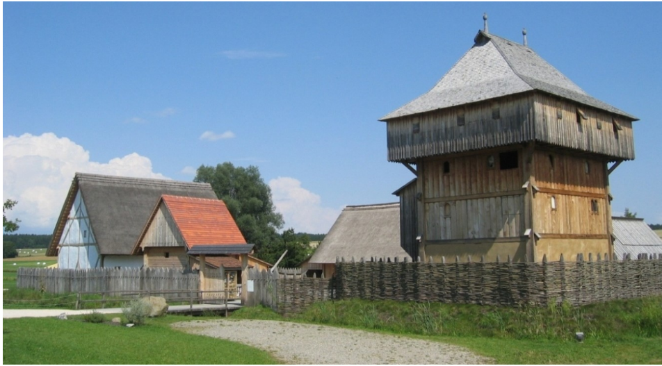
Eine weitere Turmhügelburg: Die Bachritterburg in Kanzach, Oberschwaben. Holzbauweise. Sie konnten aber auch als Steinburgen gebaut werden. Der Turm stellt hier die Kernburg dar, die restlichen Gebäude die Vorburg. Zur Orientierung: Der Burgstall dazu befindet sich ca. 100 m hinter dem Fotografen.
